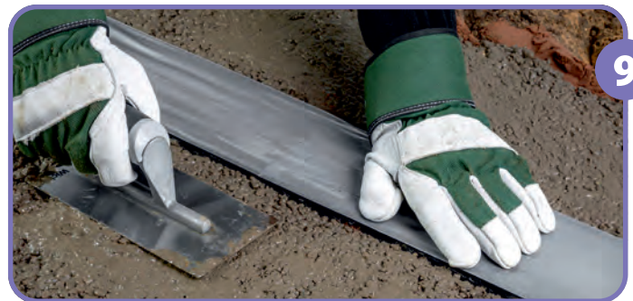
יש לשפוף בטון כך שיהיה גבוה יותר ב-2 מ"מ מעל הסבכה ולתת לו להתייבש במשך 72 שעות.
